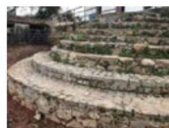
(c) antigos e novos degraus de pedra - 01
