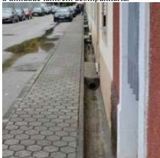
Figura 02 – Alternativa utilizada em Coimbra – Portugal que permitiu a elevação da via sem elevar o lençol freático. Fonte: Acervo Arte Real Arquitetura.
