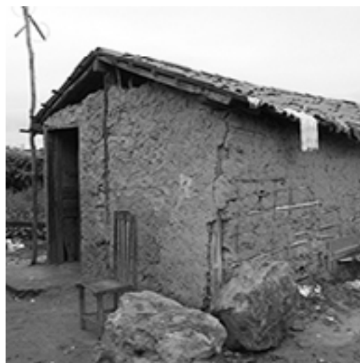
Figura 4. Habitação em Taipa no Bairro São Sebastião, Zona Sudeste de Teresina. Foto: Nelson Barbosa, 2018.
