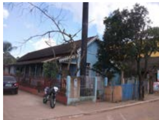
Figura 02 - Residência de Florentina Esteves em 2012. Fonte: SICG/IPHAN-AC. Data: 2013.
