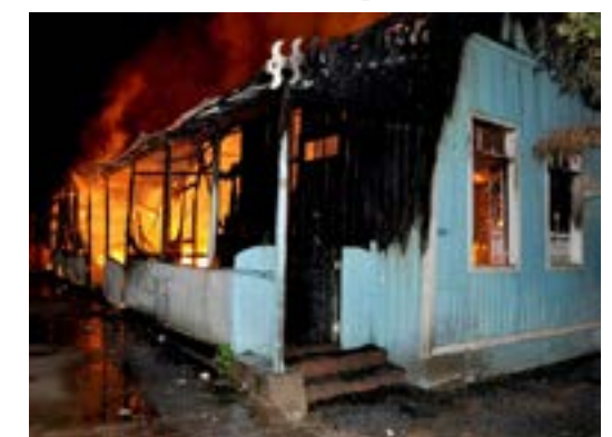
Figura 03 – Incêndio na Casa de Florentina Esteves.
