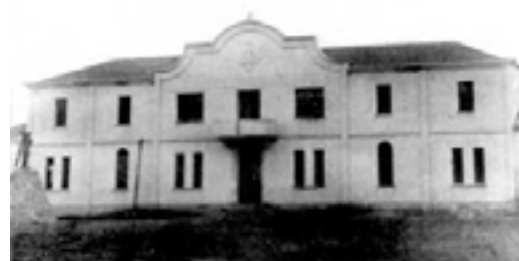
Figura 2 - Fachada Original do Colégio Normal Francisca Mendes, em 1939.
