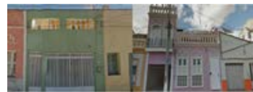
Figura 05: Fachadas com alterações na coberta.
