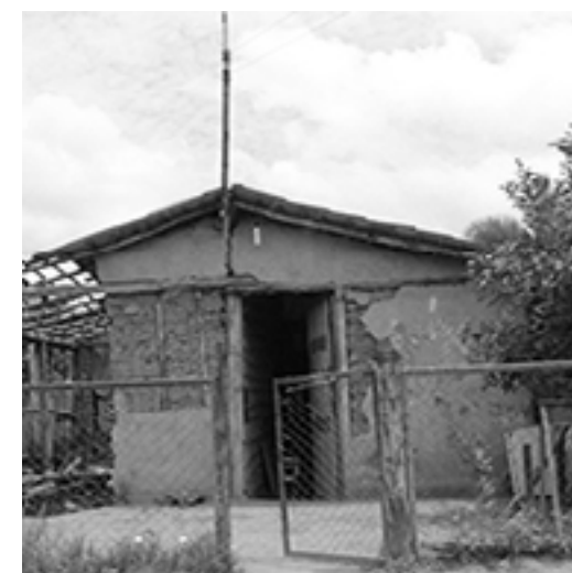
Figura 3. Habitação em Taipa no Bairro Ininga, Zona Leste de Teresina. Foto: Nelson Barbosa, 2018.
