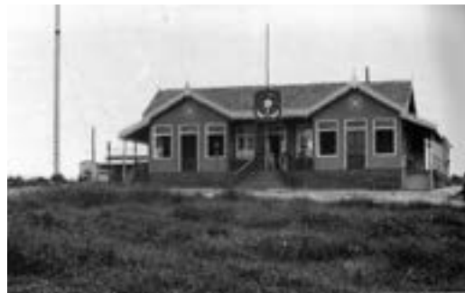
Figura 01 - Sede da Prefeitura do Departamento do Alto Acre, construída em 1908. É um dos possíveis chalés em madeira importados para abrigar os serviços públicos. Fonte: DPHC. Data: 1911-1913.
