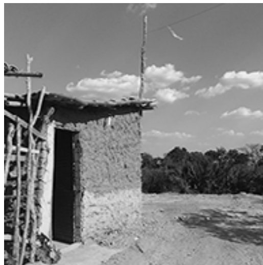
Figura 1. Habitação em Taipa no Bairro Mafrense, Zona Centro/Norte de Teresina. Foto: Nelson Barbosa, 2015.
