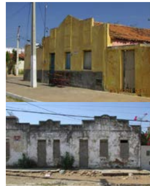
Figura 03 e 04 – Edificações com fachadas contendo uma quantidade significativa de janelas com dimensões elevadas Fonte: Autoria própria.
